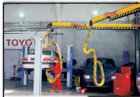
Санкт-Петербург. СТО "Тойота-Центр-Авто". Вытяжные устройства VEGA на двухбалочных консолях для обслуживания трех рабочих мест.
