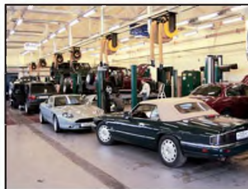
г. Москва. Технический центр "Муса-Моторс". Оснащение рабочих мест вытяжными катушками с Y-образным шлангом на две выхлопные трубы.
