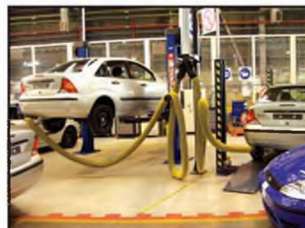
г.Всеволожск. Завод "Форд". Вытяжное устройство "Дроппер", обслуживающее два стационарных рабочих места.
